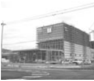
産業団地整備事業 (株)アイケープラスト 建設工事
